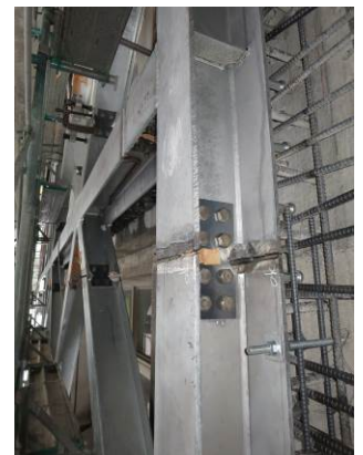
図7 補強鉄骨部材のディテール
