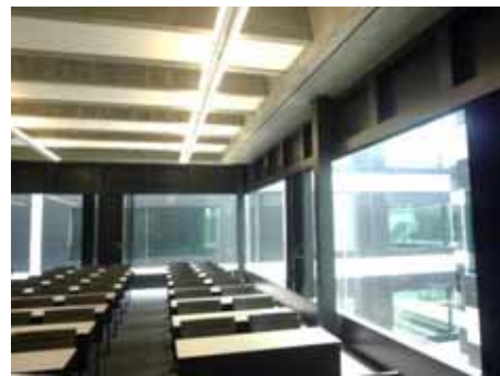
写真 23 鉄骨柱とプレキャスト床版
