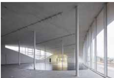
写真 19 展示室の屋根と鉄骨柱
