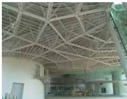
写真 16 エントランスホールの天井
