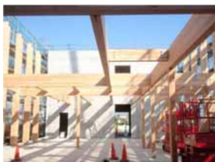
写真2 つくば研修センターの施工
