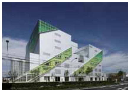
写真9 改修後の浜松サーラ
