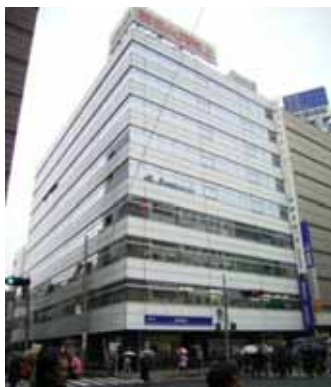
写真5 改修前の上野ビル
