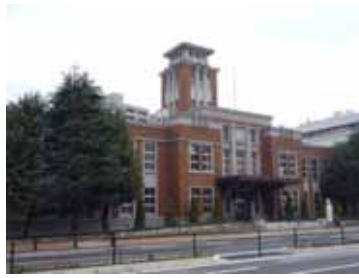
写真 10 旧戸畑区役所外観
