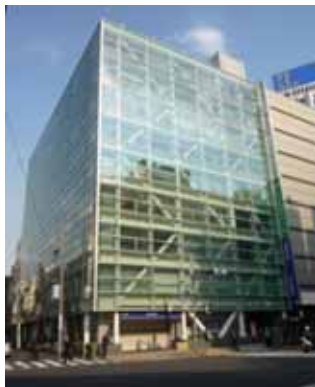
写真6 改修後の上野ビル
